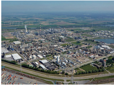
ベルギー BASF社アントワープ工場
