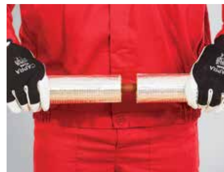
Figura 3 – Unirea fără goluri a izolațiilor
