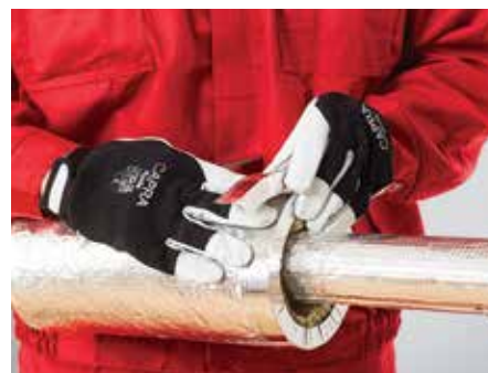
Figura 22 – Etanșarea izolației cu bandă din aluminiu
