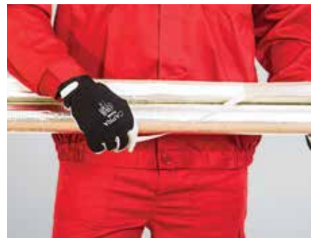
Figura 2 – Îndepărtarea foliei de protecție PE de pe suprafața autoadezivă
