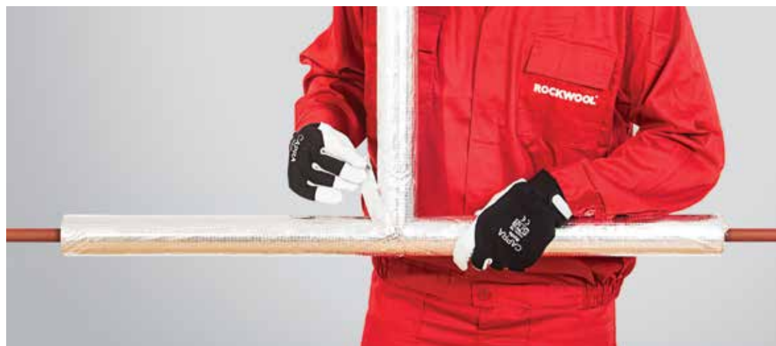
Figura 19 – Lipirea îmbinărilor cu bandă autoadezivă din aluminiu
