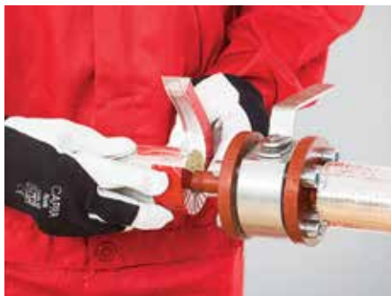
Figura 23 – Sigilarea capetelor secțiunilor drepte cu bandă din aluminiu
