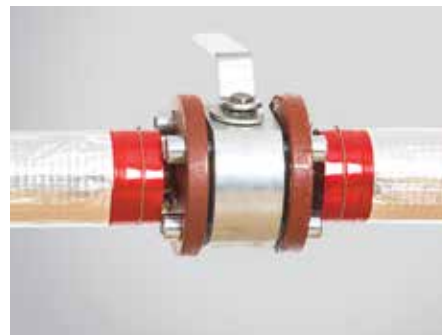
Figura 24 – Izolația finalizată în cazul în care supapa nu poate fi izolată
