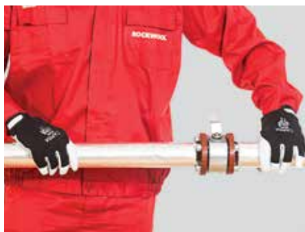
Figura 20 – Izolarea secțiunilor drepte ale fittingurilor până la supapa de închidere
