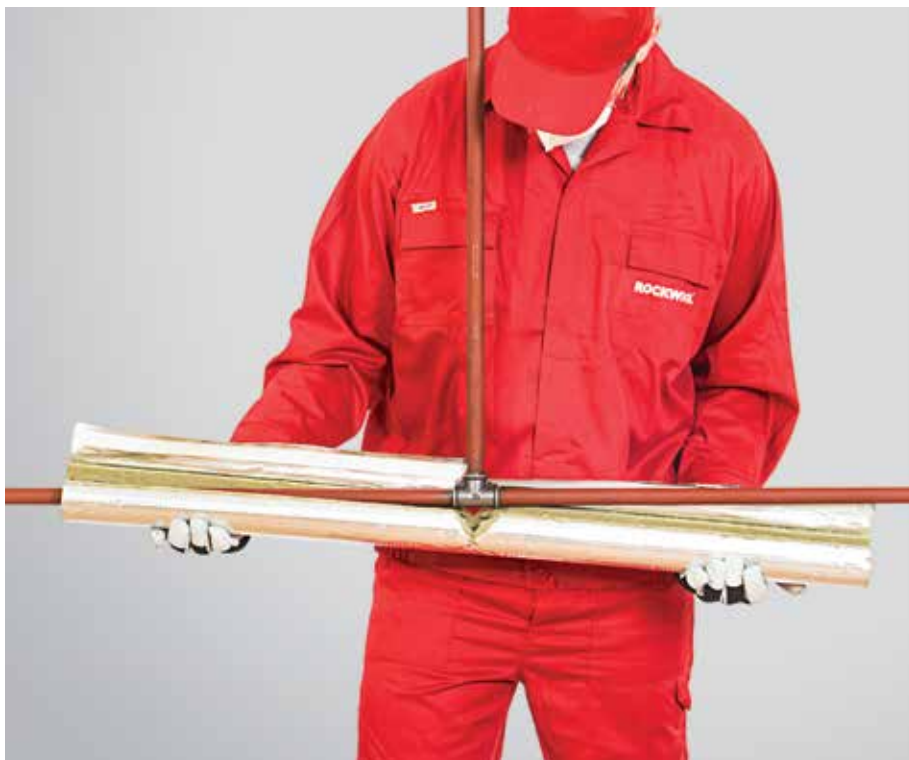
Figura 17 – Montarea elementelor pe brațele racordului în T
