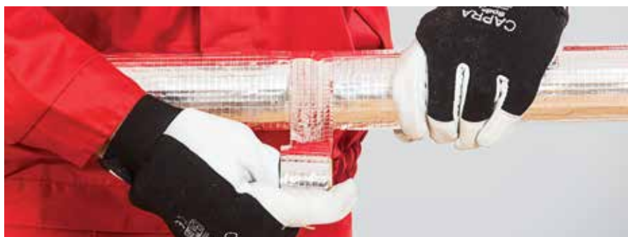
Figura 4 – Etanșarea îmbinărilor cu bandă din aluminiu
