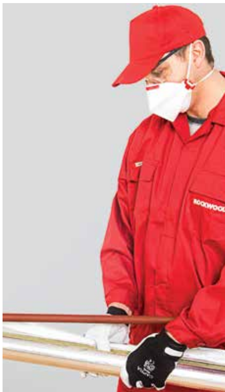
Figura 1 – Poziționarea izolației
