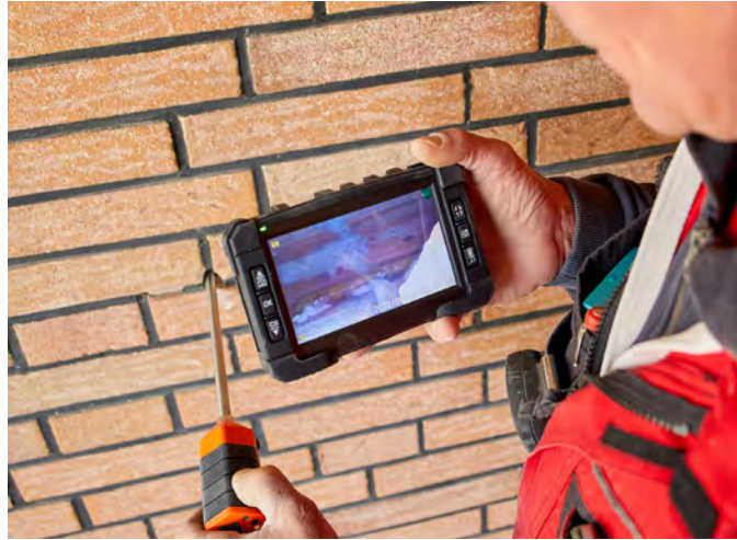
Zu Beginn wird die Wand bzw. die Hohlachicht an mehreren Stellen mittels eines Endoskops auf ihre Beschaffenheit hin untersucht.
