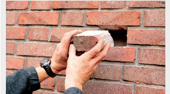
Aus dem Vormauerwerk wird ein ganzer oder ein halber Ziegel entnommen.
