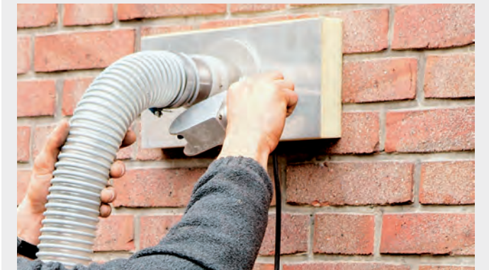
Die Großdüse wird aufgesetzt und der Hohlraum ausgeblasen.
