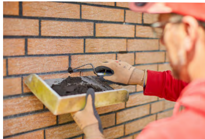
Selbstverständlich werden die Bohrlöcher nach dem Einblasvorgang wieder sauber verfügt ...
