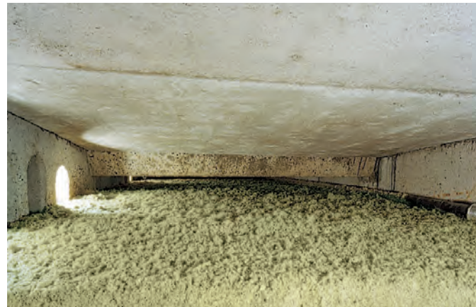
Mit Fillrock RG gedämmtes belüftetes Flachdach
