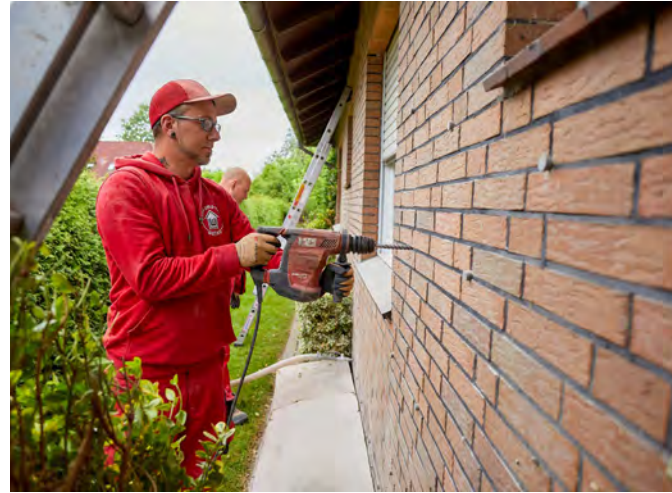
Im Anschluss erfolgen Bohrungen in die T-Fugen der Fassade in gleichmäßigen Abständen.
