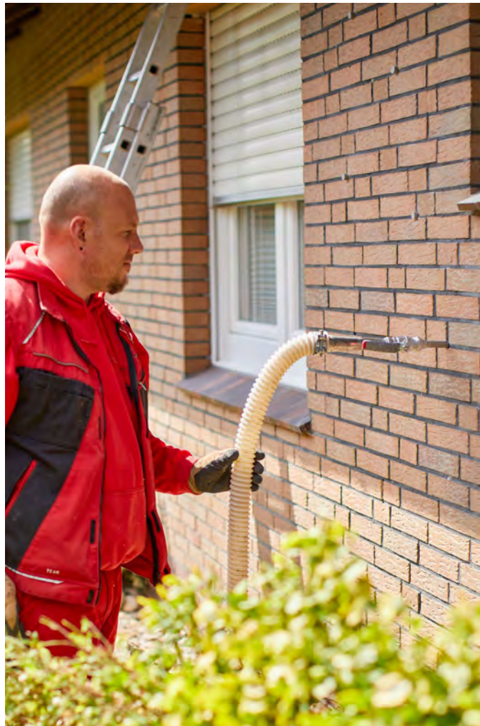
Die Hohlachicht wird nun mit einer oder mehreren Einblasmaschinen mit den passenden Düsen befüllt.
