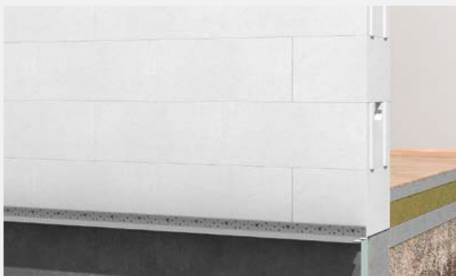
Mocowanie listwy cokołowej.
