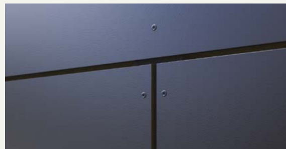
2. HPL a vláknocementové desky: Spáry musí být široké nejméně 10 mm.
