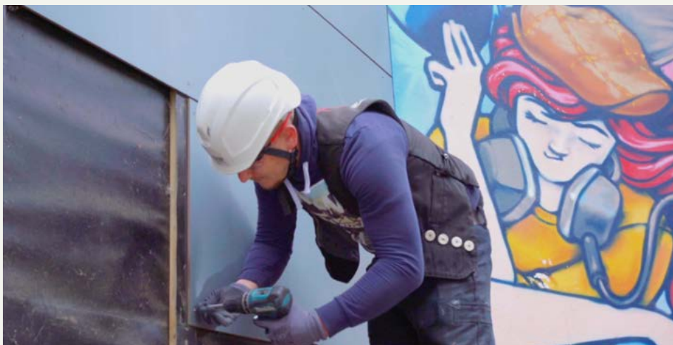
Snadná demontáž desek Rockpanel
