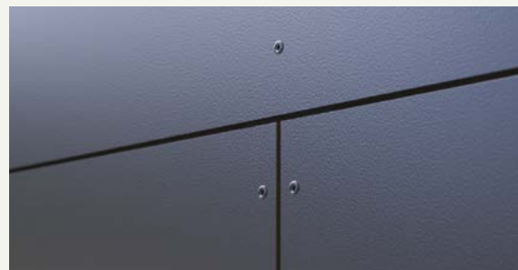
1. Rockpanel: Vysoká rozměrová stálost umožňuje úzké spáry mezi deskami.
