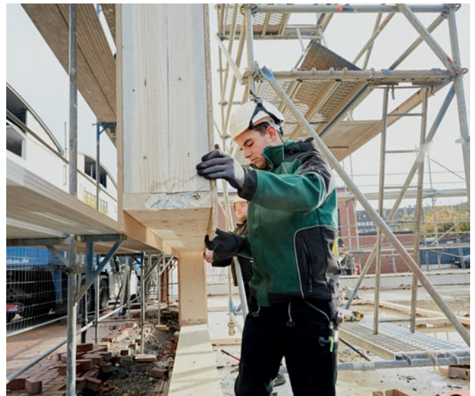
Schnelle und saubere Montage der in der Werkstatt vorgefertigten Elemente
